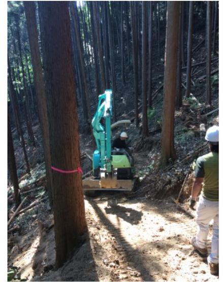
あまり難しい計測などしないで、ヘアピンカーブの中心から各6.5mの間隔で掘り進んでいきます。このようなことを、現場で聞きながら実際のメアスをピンクのテープでつけながら作業道の設計をしていきます。初日はこれで終了！その後はバーベキューなどのイベントがありましたが、疲れているので、ホテルへ直行！
